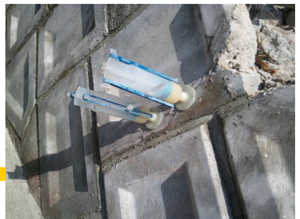
エポキシ樹脂 注入作業
