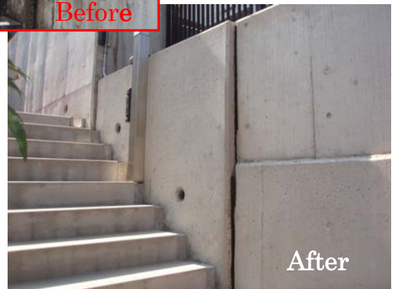
洗浄・コーティング 【コンクリート面】 施
