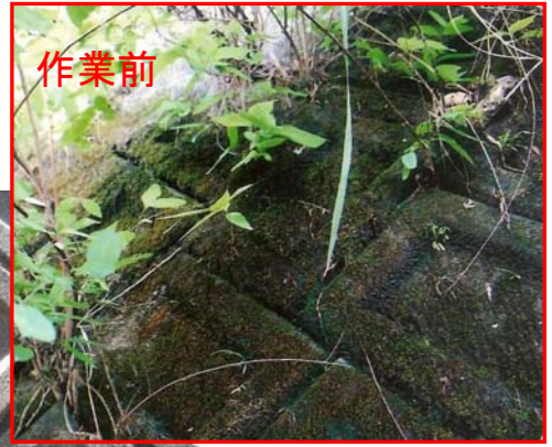
目地修復 作業完了
