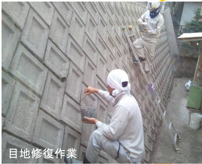
目地隙間修復作業
